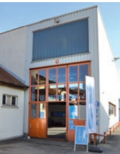
Le Vilebrequin est installé dans les anciens locaux de la SAFED.
